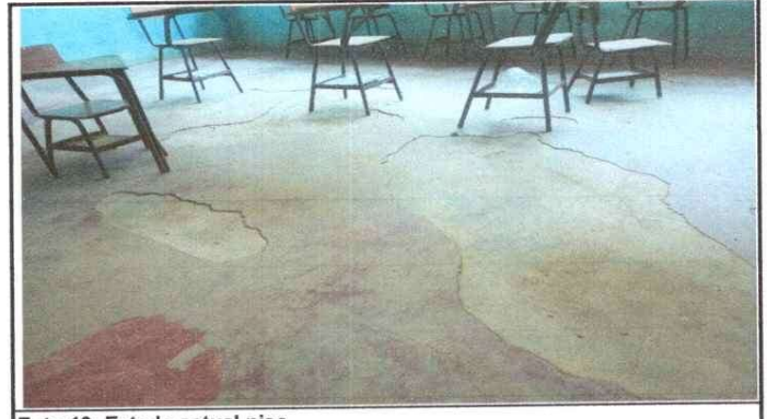
Foto 10: Estado actual piso.
