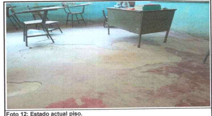
Foto 12: Estado actual piso.
